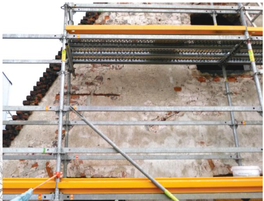
2016 r. - Wrocław - Remont XVIII-wiecznej zabytkowej kamienicy Oppenheimów przy placu Solnym we Wrocławiu. Wzmocnienie nadproży i murów ceglanych systemem Helifix oraz montaż na elewacji punktów mocowania dekoracji sezonowych. Projekt zrealizowano pod nadzorem konserwatorskim.
