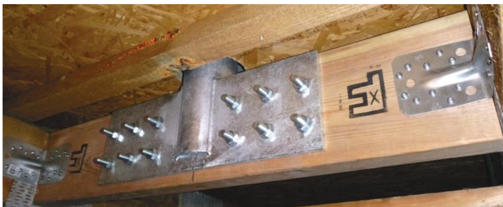
■ 2016 r. - Kraków - Projekt i wykonanie wzmocnienia attyki pawilonu handlowego. Do konstrukcji dachu zamocowano dodatkowe zastrzały stalowe podpierające najwyższą część attyki.
