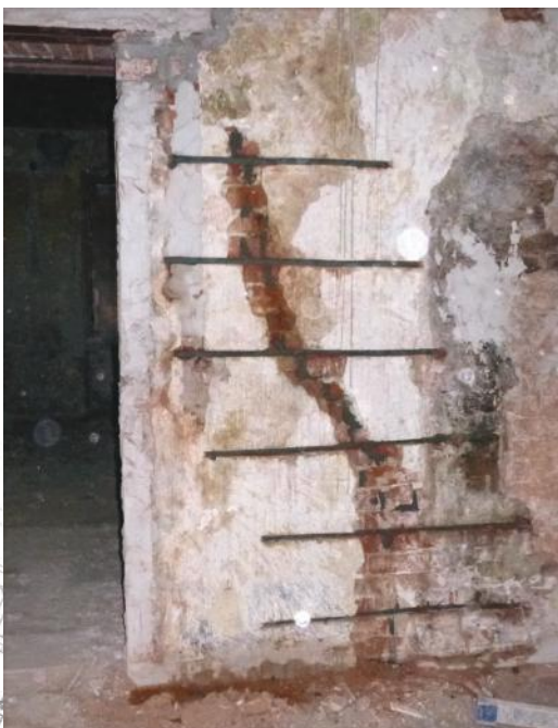
2016 r. - Wrocław - Remont XVIII-wiecznej zabytkowej kamienicy Oppenheimów przy placu Solnym we Wrocławiu. Wzmocnienie nadproży i murów ceglanych systemem Helifix oraz montaż na elewacji punktów mocowania dekoracji sezonowych. Projekt zrealizowano pod nadzorem konserwatorskim.
