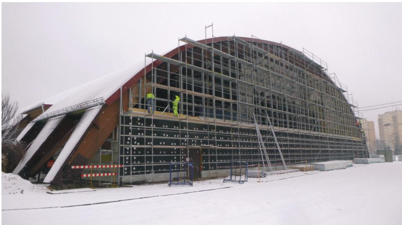
■ 2016 r. - Zgierz - Naprawa i wzmocnienia łukowych dźwigarów z drewna klejonego o rozpiętości 60 m hali sportowej MOSiR. Dokonano wymiany skorodowanych lameli drewnianych, iniekcji spękań żywicami epoksydowymi oraz wzmocnienia stref podporowych.
