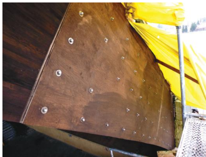
■ 2016 r. - Zgierz - Naprawa i wzmocnienia łukowych dźwigarów z drewna klejonego o rozpiętości 60 m hali sportowej MOSiR. Dokonano wymiany skorodowanych lameli drewnianych, iniekcji spękań żywicami epoksydowymi oraz wzmocnienia stref podporowych.
