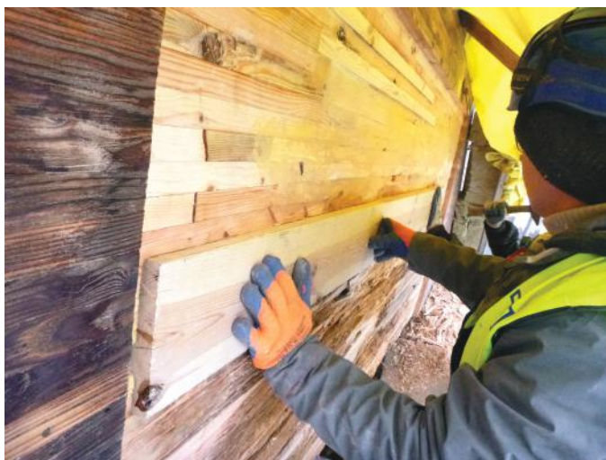
■ 2016 r. - Zgierz - Naprawa i wzmocnienia łukowych dźwigarów z drewna klejonego o rozpiętości 60 m hali sportowej MOSiR. Dokonano wymiany skorodowanych lameli drewnianych, iniekcji spękań żywicami epoksydowymi oraz wzmocnienia stref podporowych.
