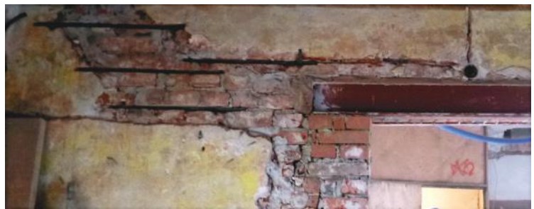
2016 r. - Wrocław - Remont XVIII-wiecznej zabytkowej kamienicy Oppenheimów przy placu Solnym we Wrocławiu. Wzmocnienie nadproży i murów ceglanych systemem Helifix oraz montaż na elewacji punktów mocowania dekoracji sezonowych. Projekt zrealizowano pod nadzorem konserwatorskim.
